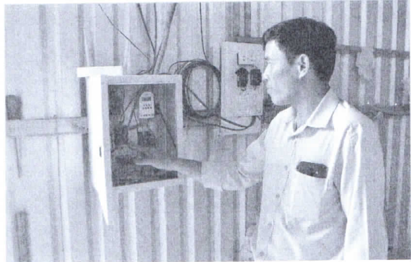
Ông Huỳnh Sa Rây, Tổ trưởng tổ trồng màu công nghệ cao ấp Hòa Lạc A đang điều chỉnh hệ thống đồng hồ tự động hẹn giờ tưới phun dưa lưới.
